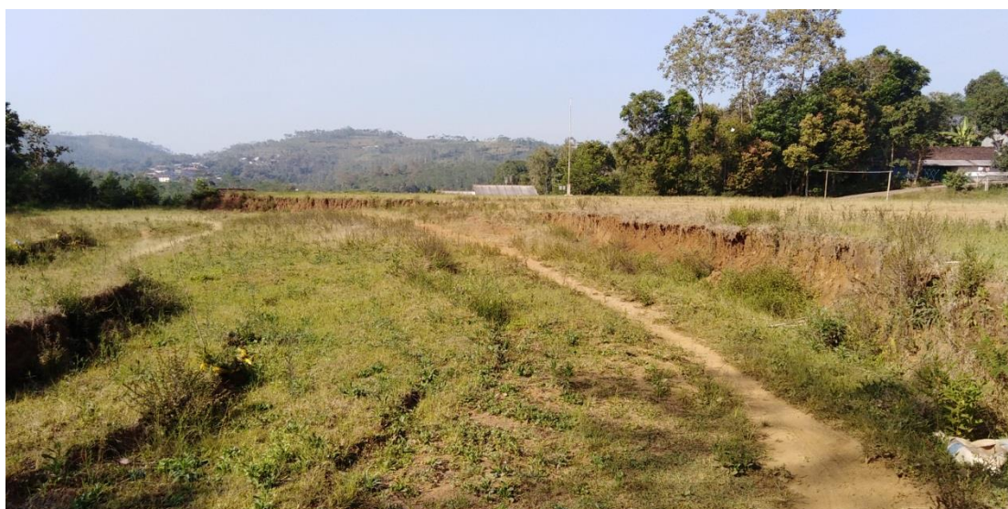
Gambar 1 Lapangan Pandanmurti di Desa Candigaron, Sumowono, Kabupaten Semarang yang mengalami fenomena gerakan tanah seperti terbelah
